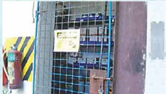
Chemical Storage Area- Caution Signage, Fire Extinguisher Nearby രാസവസ്തു സംഭരണ മേഖല - ജാഗ്രതാ ചിഹ്നങ്ങൾ, അടുത്തുള്ള അഗ്നിശമന യന്ത്രം
